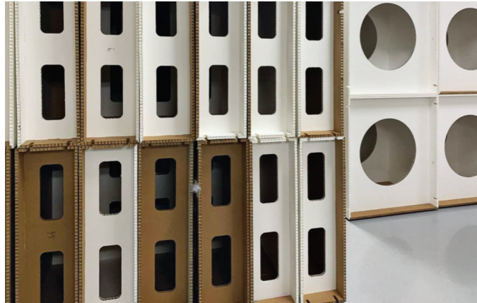
도8. 허니콤보드 벽체 시공 모습
